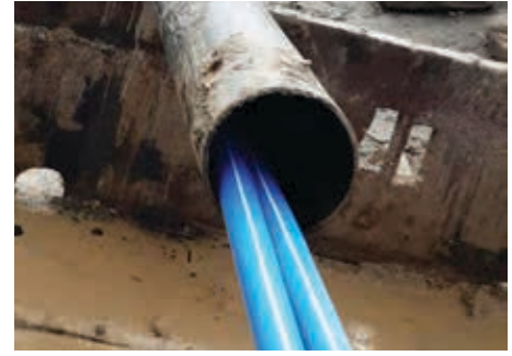
Jia Bhareli HDD 6 inch conduit pulling
